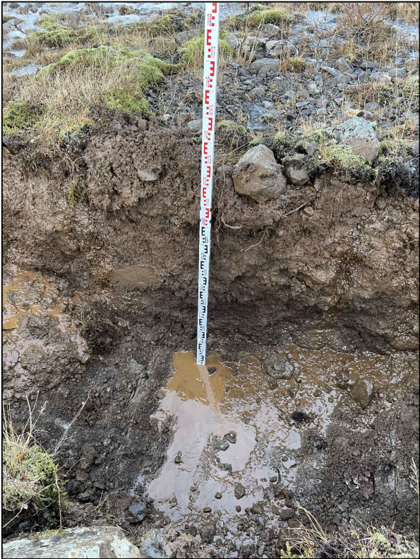
Horft í Holu E. Moldarblandaður jarðvegur með grús og einstaka steinum niður á klöpp á 1,3 m dýpt
