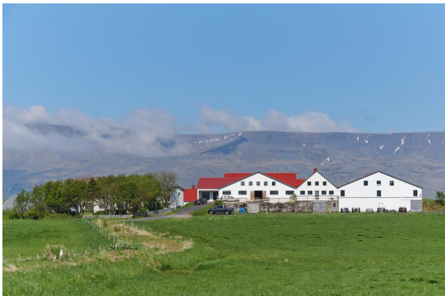
MYND 4 Blikastaðabærinn. Mynd: Alta.
