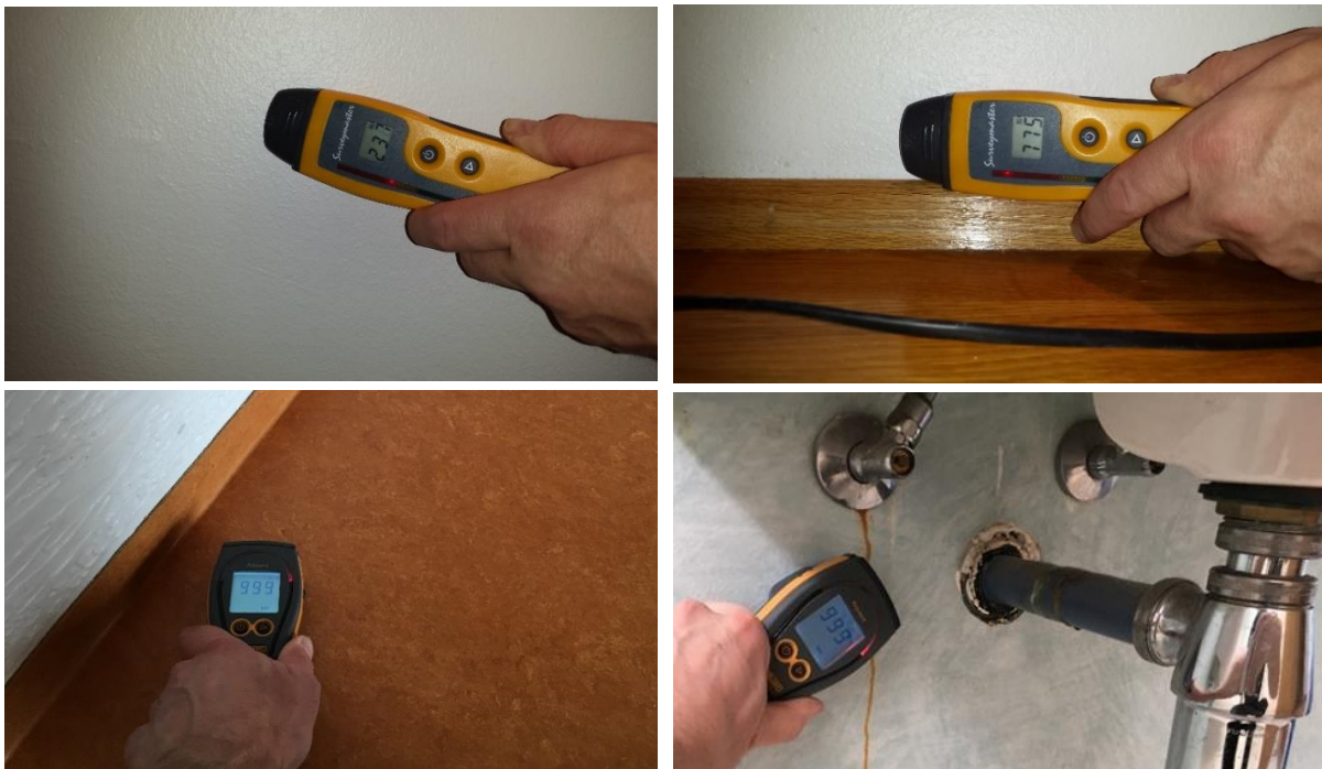
MYND B. Dæmi um viðmiðunarmælingu, merkt er inn á teikningu hækkaður raki á vegg neðst við gólf. Merkt er inn á teikningu hækkaður raki í gólfi við útvegg. Merkt inn á teikningu hækkaður raki í vegg neðan við vask.
