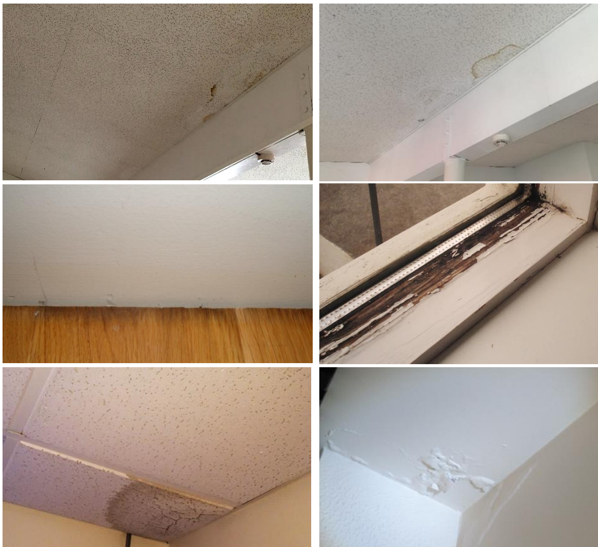
MYND A. Dæmi um ummerki sem er sett athugasemdir við í sjónrænni skoðun.
