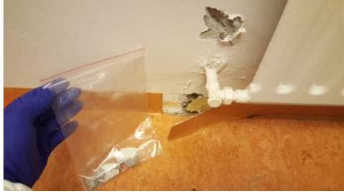
MYND F Sýnataka úr vegg
