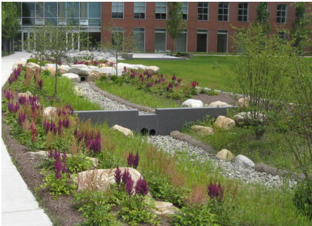
Mynd 3-6 Dæmi um ofanvatnsrás með flæðisstýringu 5
