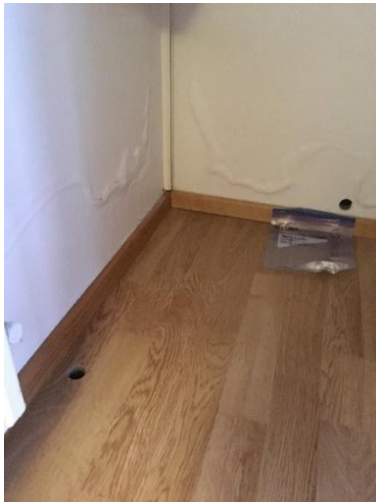
MYND 12: Sýni 7–Yngri deild, suðurálma, starfsmannarými, útvegur, málning og múr.
